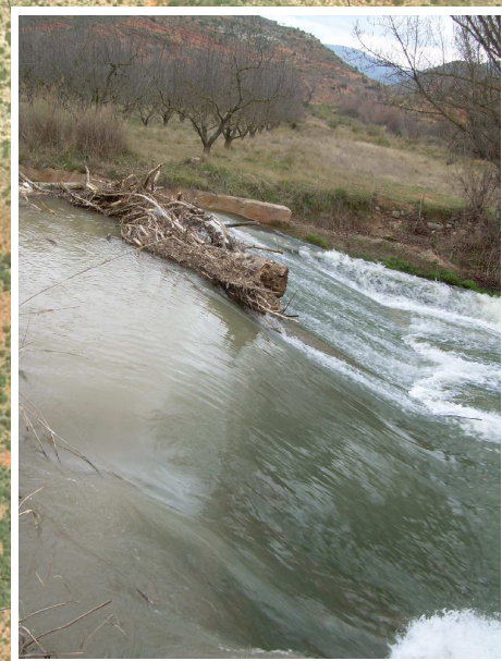
FOTO 12. Azud Libros para riego, de 2m de altura y hormigón.
