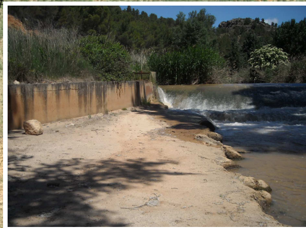
FOTO 14 . Canal de derivación del azud
